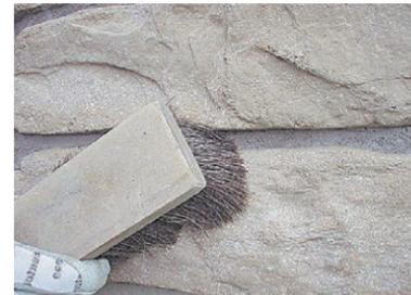
目地パック等を使用して、モルタル目地材を詰めていきます。目地材の硬化を確認した後、竹べら等で余分な目地材をかき落としながら仕上げしていきます。タイル・石材の表面に付着した目地材はブラシ等で除去してください。
