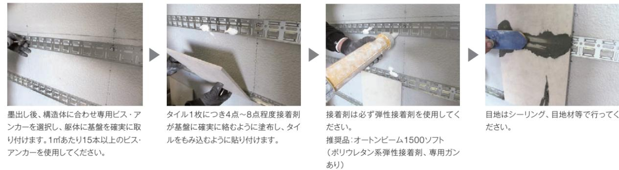
墨出し後、構造体に合わせ専用ビス・アンカーを選択し、躯体に基盤を確実に取り付けます。1㎡あたり15本以上のビス・アンカーを使用してください。
