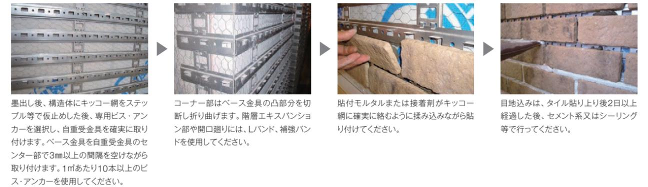
墨出し後、構造体にキッコウ網をステップル等で仮止めた後、専用ビス・アンカーを選択し、自重受け金具を確実に取り付けます。ベース金具を自重受け金具のセンター部で3mm以上の間隔を空けながら取り付けます。1㎡あたり10本以上のビス・アンカーを使用してください。
