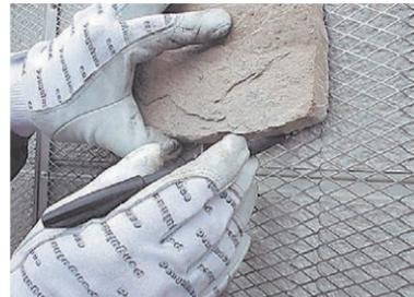
色、大きさのバランスを考えタイル・石材を割付しドットピンの割付位置に墨出しをします。タイル・石材の裏面に接着剤を1～2箇所点付けをドットピンの上へのせ、基盤に接着剤が確実に絡むように、揉み込みながら貼付けます。接着剤は必ず弾性接着剤を使用してください。
